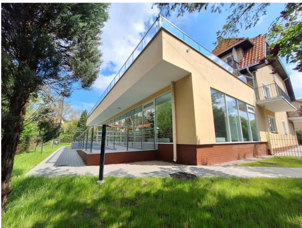
Fot. Widok rozbudowanej części Domu Pomocy Społecznej w Wielkiej Nieszawce
